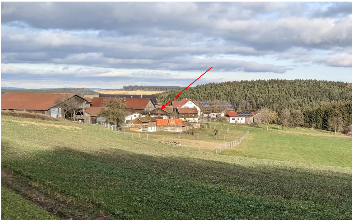
Abb.: Blick auf das Baudenkmal (Quelle: Eder Ingenieure, 2023)
